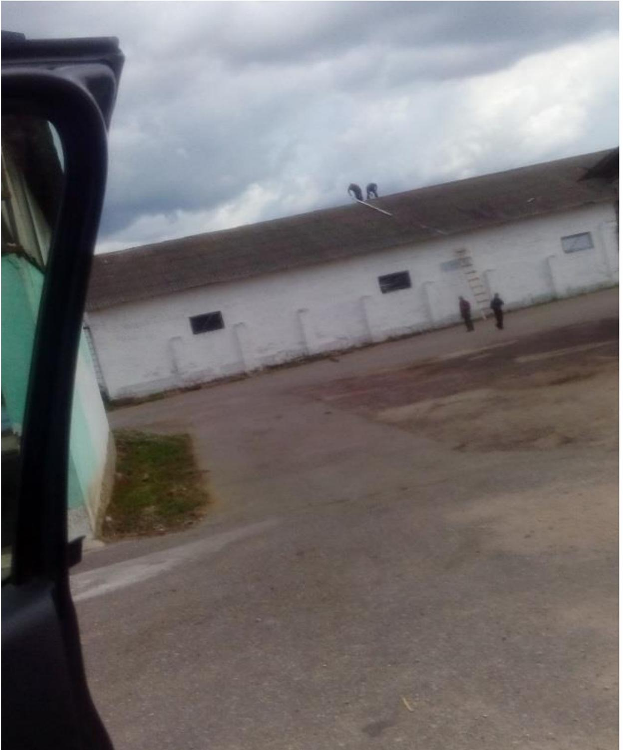
*В месте выполнения кровельных работ на крыше здания с уклоном более 20° канат страховочный, предназначенный для закрепления фала предохранительного пояса, отсутствовал.*
