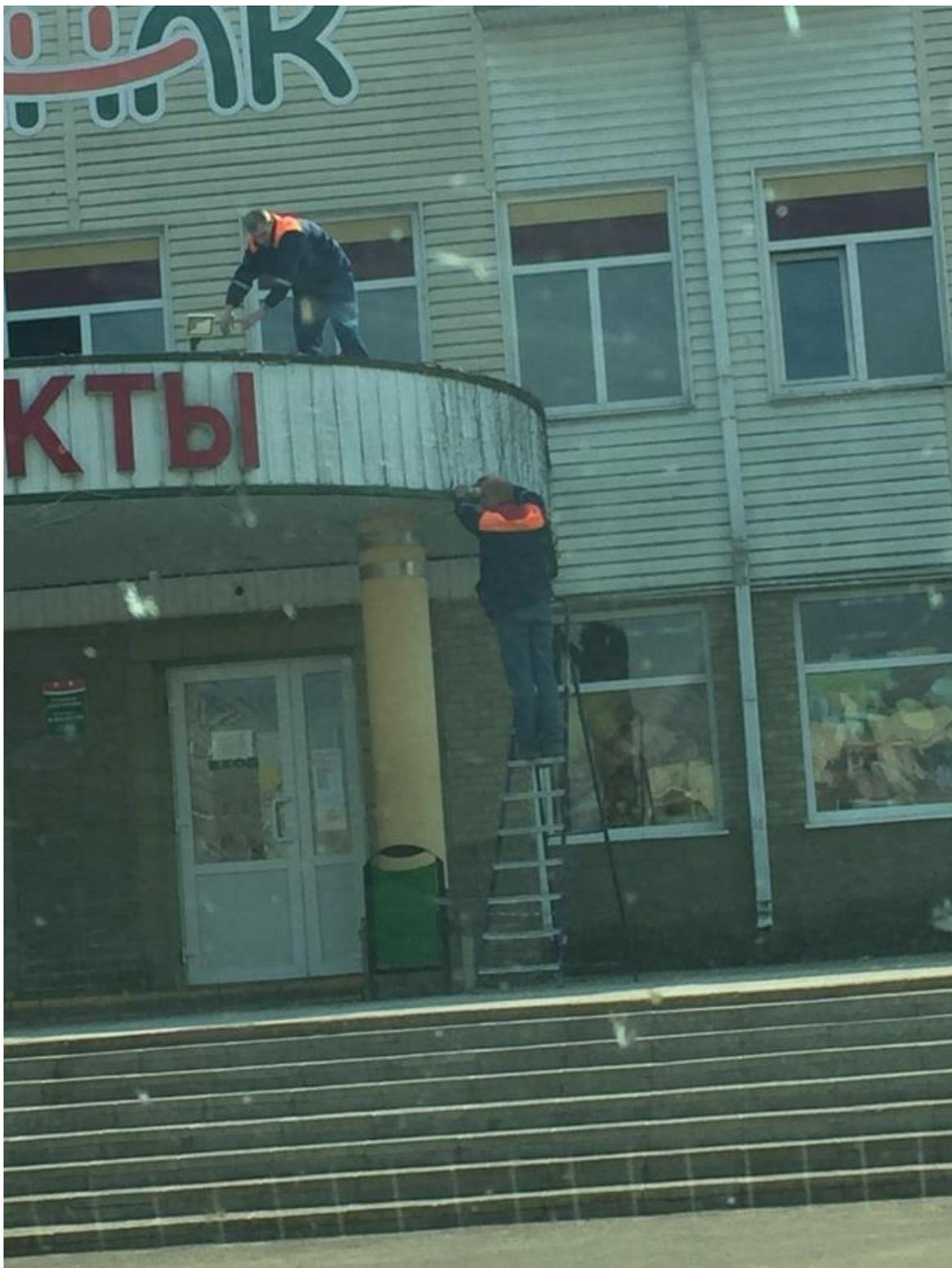
*Работающий выполнял работы на крыше здания на высоте около 3 м у неогражденного перепада по высоте без применения предохранительного пояса и каски защитной.*
