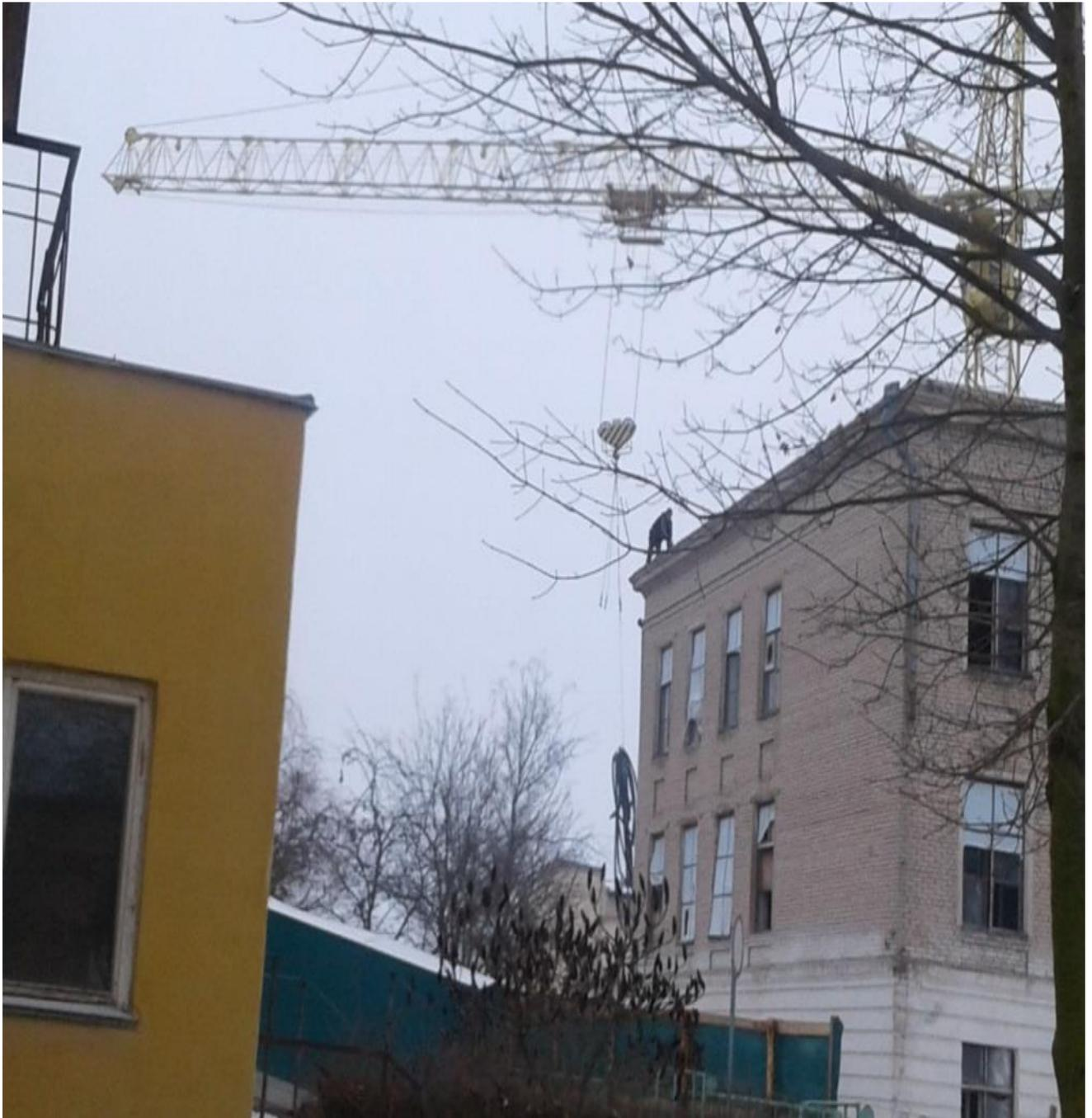
*Работник организации, выполняя работы на кровле реконструируемого здания, находился вблизи не огражденного перепада по высоте (более 5 м.), при этом фал предохранительного пояса к конструктивным элементам здания пристегнут не был.*
