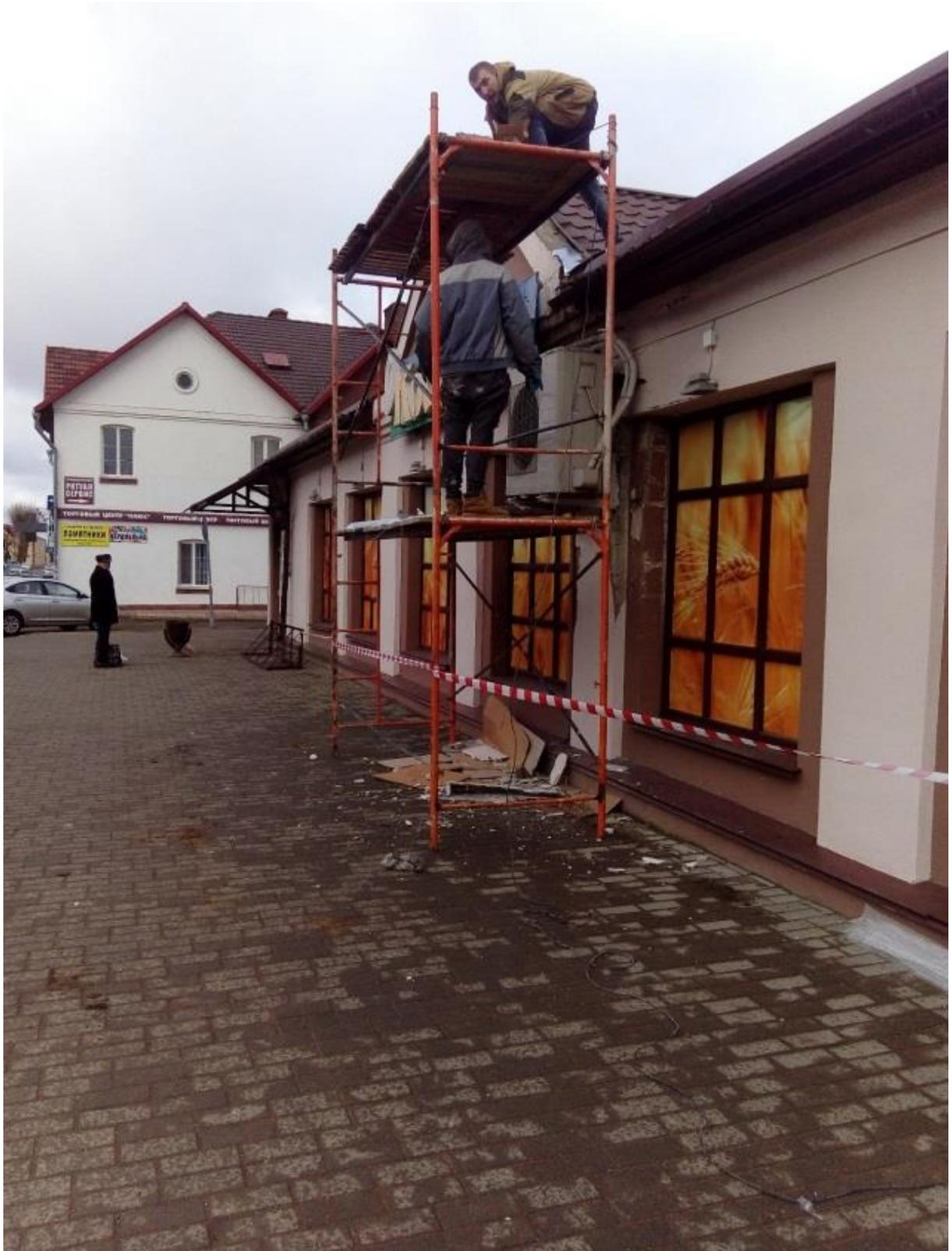
*Работающие выполняли кровельные работы, при этом один из них находился на крыше здания на высоте около 4 м и передвигался по ней возле неогражденного перепада по высоте без применения предохранительного пояса. В месте выполнения кровельных работ на крыше здания канат страховочный, предназначенный для закрепления фала предохранительного пояса, отсутствовал (закрепиться за конструкции, опоры и т.д. работникам не представлялось возможным).*
