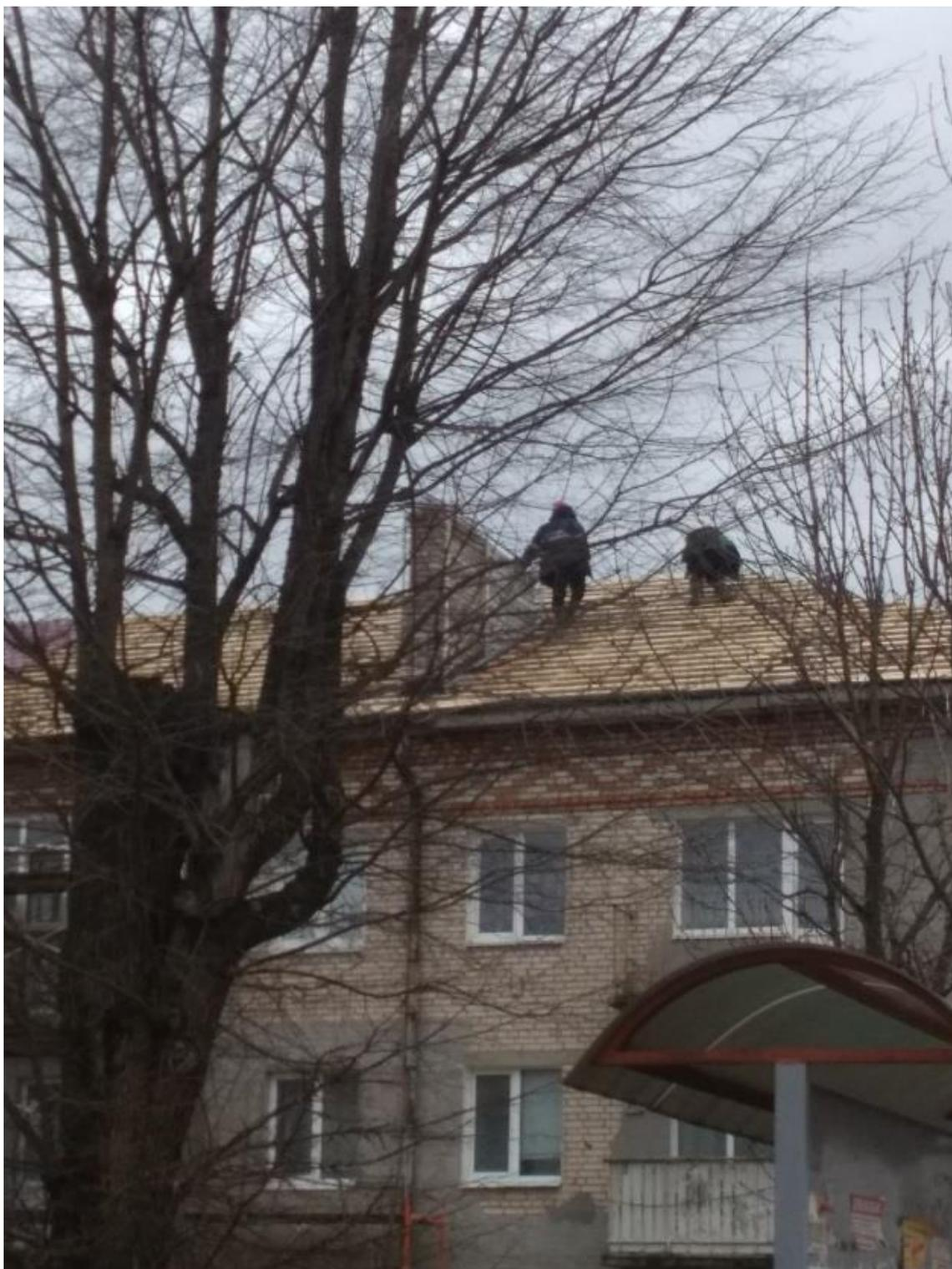
*В месте выполнения кровельных работ на крыше здания с уклоном более 20° канат страховочный, предназначенный для закрепления фала предохранительного пояса, отсутствовал. Для прохода работников, выполняющих работы на крыше с уклоном более 20°, трапы с поперечными планками для упора ног отсутствовали. Двое работников, при выполнении работ на крыше здания с уклоном более 20° и без защитных ограждений, предохранительный пояс не использовали.*
