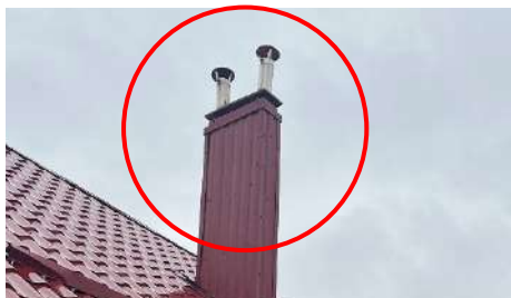
установка зонтов на дымовых каналах
